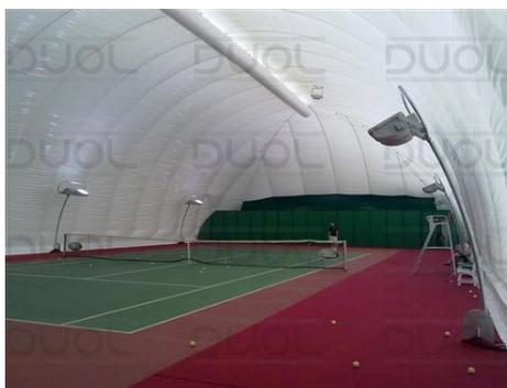
Балон хале са конструкцијом су монтажно демонтажни објекти који као конструктивно решење покривања терена користе конструкцију (метална, дрвена или тенда) преко које се постављају мембране (једнослојна, двослојна ПВЦ, термо-изолована или сендвич панели). Металне и дрвене конструкције су стандардних ширина 18м,25м и 36м, а дужина варијабилна. Систем отварања страница балона омогућава циркулацију ваздуха у летњем периоду.
