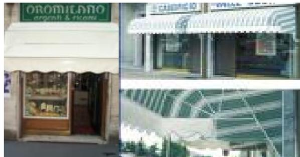
Перда је висића конзолна монтажна конструкција са покретним застором који се приликом затварања намотава или склапа у правцу фасаде зграде. Поставља се на фасаду зграде изнад зидног отвора ради заштите од атмосферских прилика и заузима део ваздушног простора над јавном површином. На површину јавне намене се не ослања ни једним својим делом.
