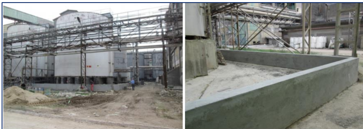
Sl.7 Rezervoari fosforne kiseline sa betonskom tankvanom
