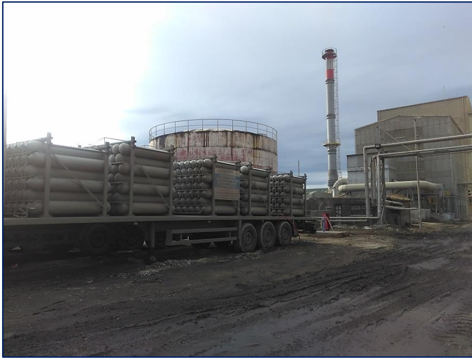
Sl.15 Položaj rezervoara za CNG u kompleksu Elixir Prahovo
