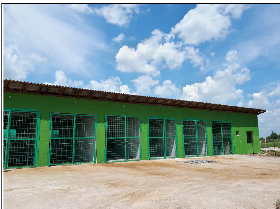
Sl.39 Privremeno skladište otpada
