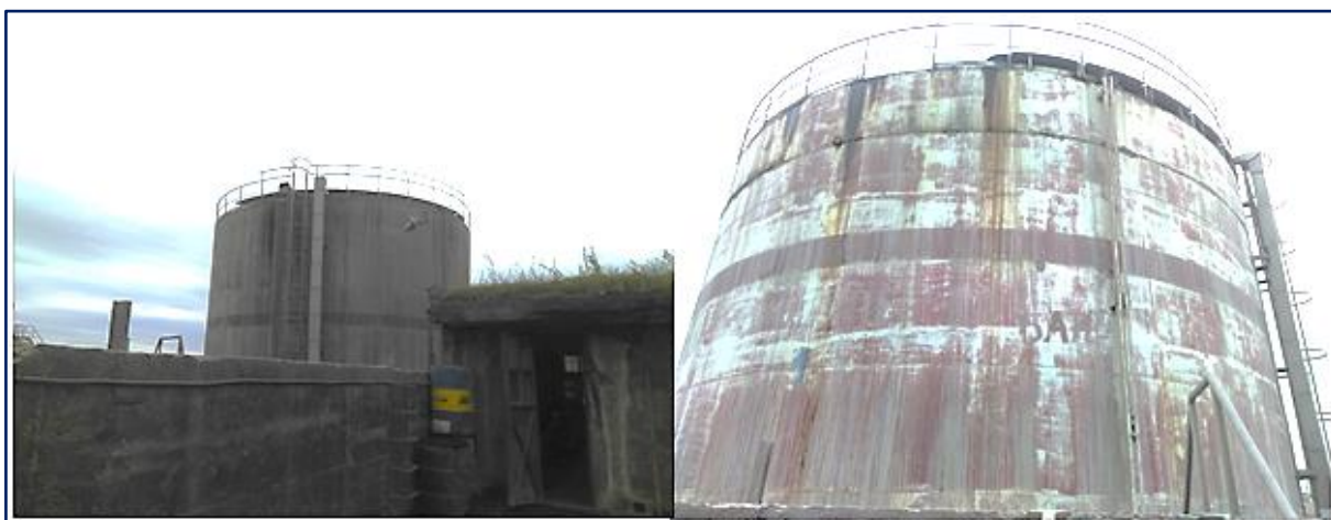
Sl.12 Izgled rezervoara za mazut
